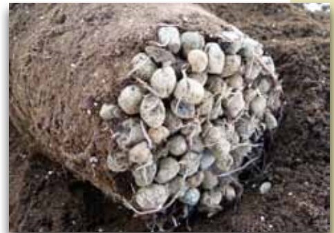
Drenaje a base de arlita
